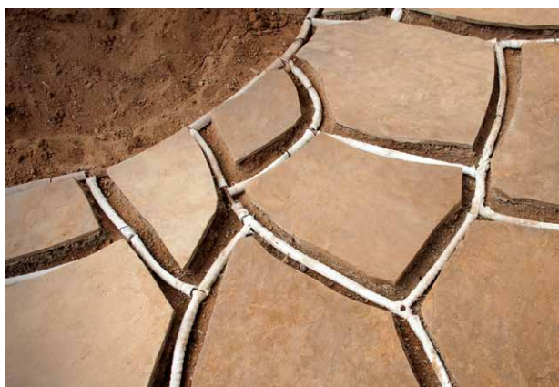
Пример установки Eco-Wrap
