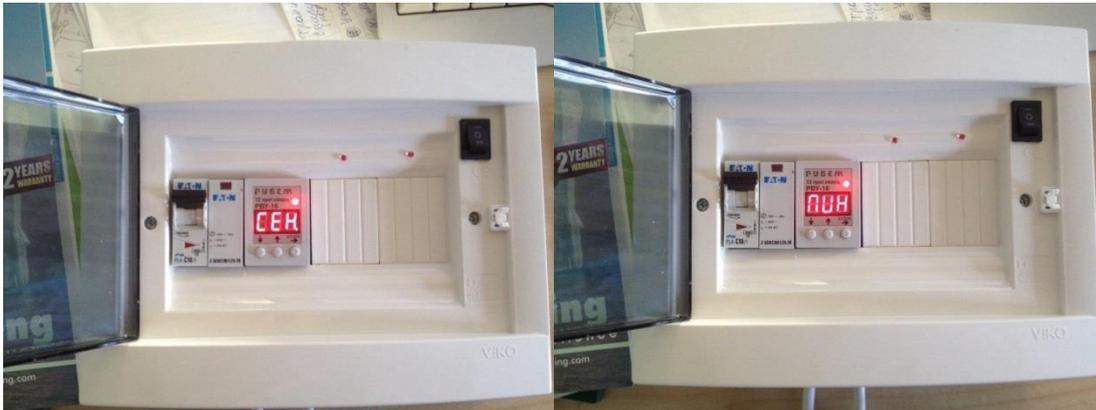
4. Выбирая надпись t2(время паузы) нажимаем стрелку «в сторону»(кнопка 4) еще раз... Повторить цикл программирования по пункту «3» данной инструкции. Вышеизложенный цикл программирования настраивает время «паузы» насоса.
