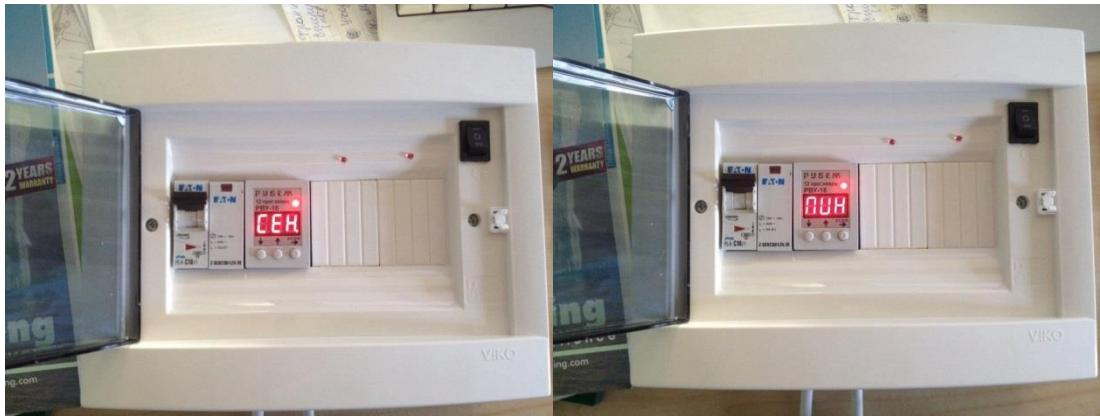
4. Выбирая надпись t2(время паузы) нажимаем стрелку «в сторону»(кнопка 4) еще раз... Повторить цикл программирования по пункту «3» данной инструкции. Вышеизложенный цикл программирования настраивает время «паузы» насоса.
